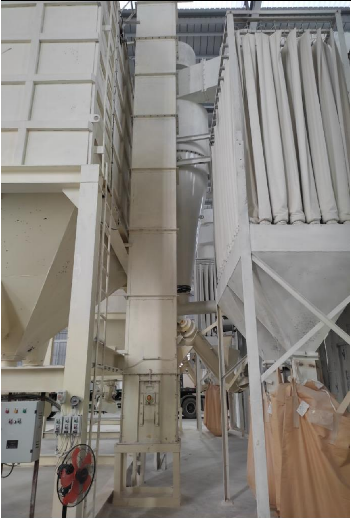
Hình 3.4. Hệ thống lọc bụi túi vải và hệ thống gàu tải bụi
