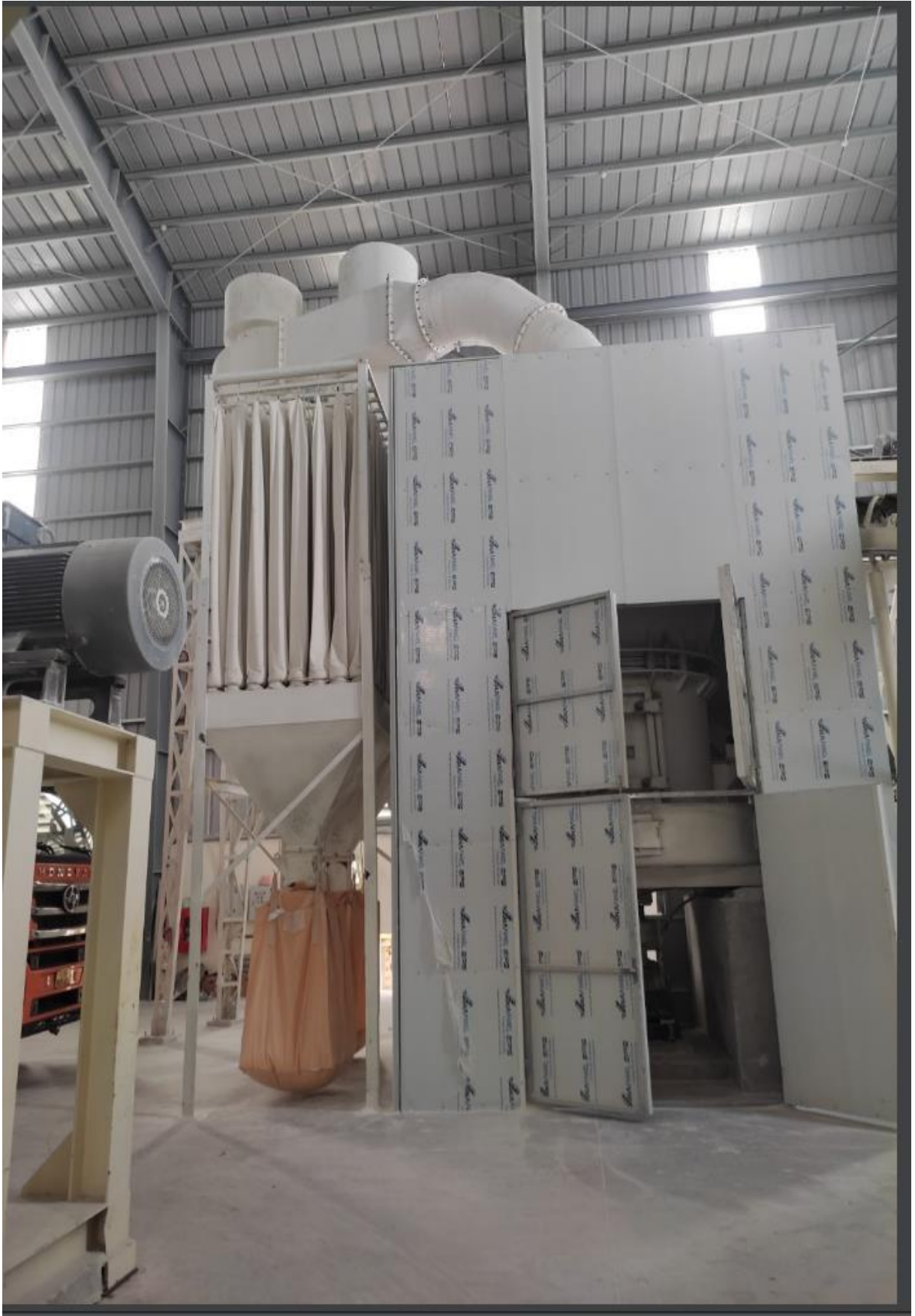
Hình 3.3. Hệ thống lọc bụi túi vải tại máy nghiền bột đá
